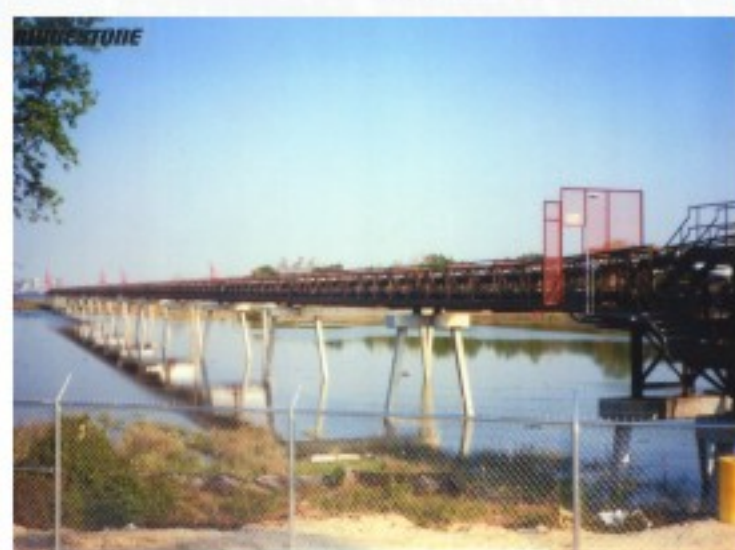
管状带式输送机于1979年在日本最早应用, 经过近年来一定的完善与发展, 主要用于输送常温散装物料, 如煤、矿石、粮食、灰渣等散装物料。
